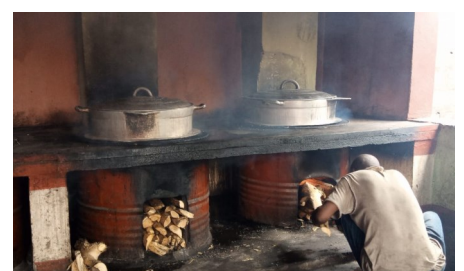
Réhabilitation et équipement de la cuisine dans l'établissement pénitentiaire de Manakara
